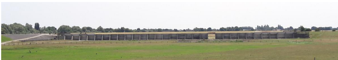
Figuur 2.2 Regelwerk Hondsbroeksche Pleij, van de 30 openingen is er slechts 1 open (foto N. Asselman).
