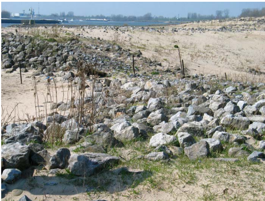
Foto 7 Oude basaltbeschoeiing langs de Waal, bij Millingen (Foto: Theo van der Sluis).
