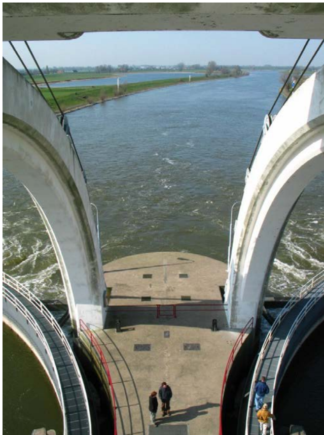
Foto 9 De Nederrijn wordt momenteel nog gestuwd voor de scheepvaart. Hier de stuw bij Doorwerth (Foto: Theo van der Sluis).
