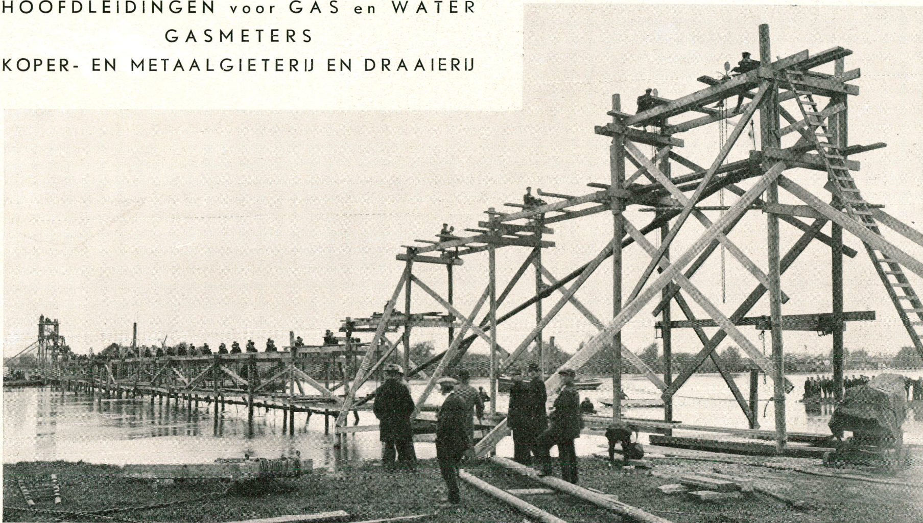
HET LEGGEN VAN EEN WATERLEIDING ZINKER, INWENDIG, WIJD 200 m/m DOOR DE RIVIER DE IJSSEL TE ZUTPHEN
