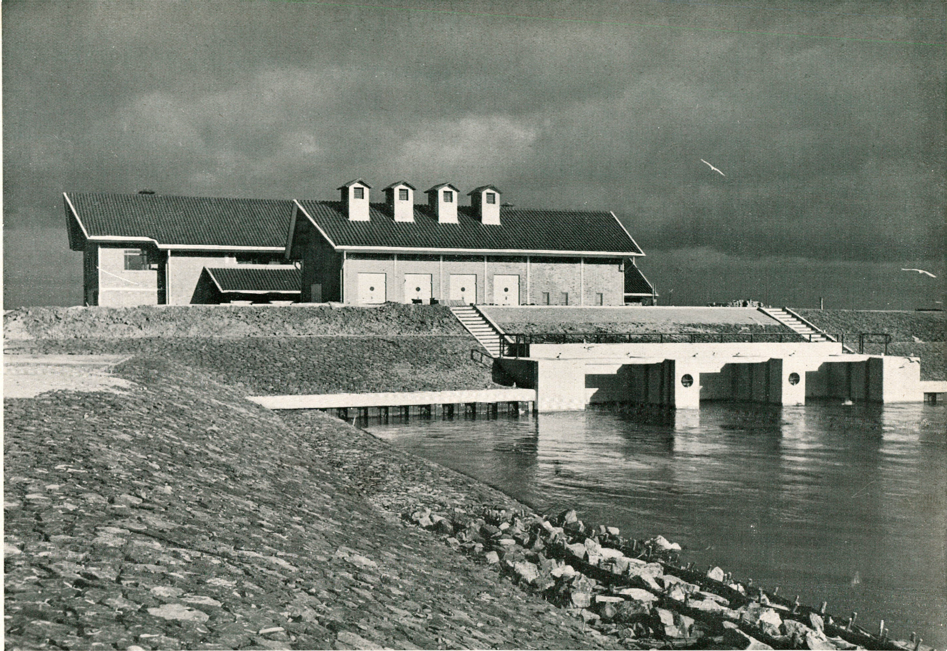
9. Gemaal te Lemmer, pers- zijde met transformatorgebouw
