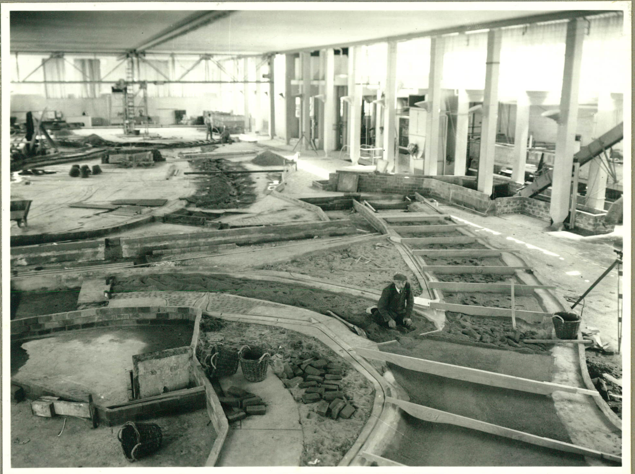
7. Onder profiel brengen van het rivierbed.
