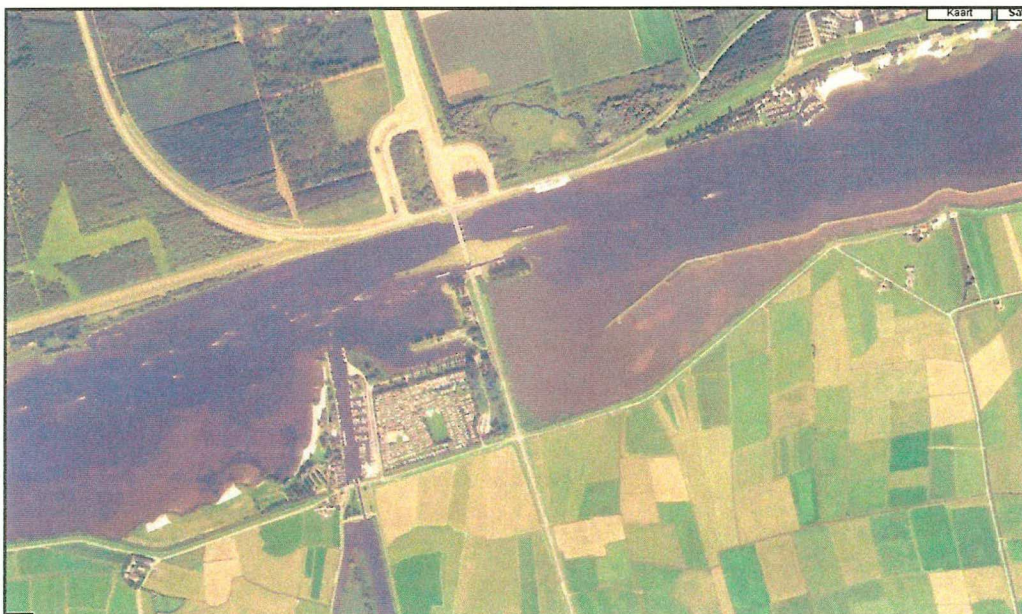
Figuur 1-1 Ligging van de Nijkerkersluis
