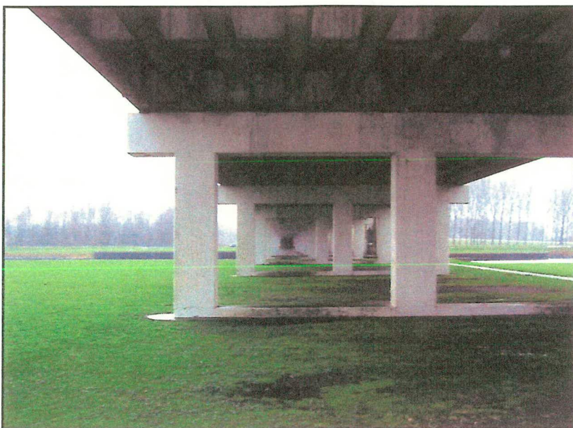
Figuur 4-1 Foto onderkant brug over middeneiland
