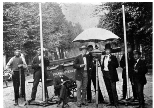
Figuur 4.2: Eerste waterpassing in 1880 met ir. C. Lely (witte hoed) naast het Camida waterpasinstrument.
