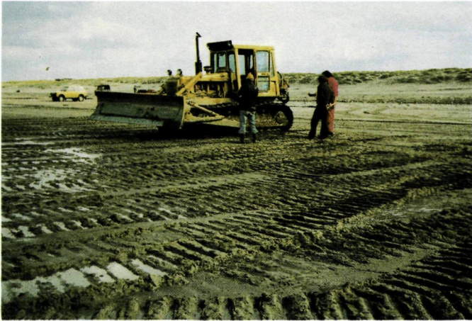
Diverse machinale schuifmiddelen zijn uitgetest als schuifmiddel, zoals hier de bulldozer op rupsbanden.
