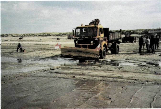
De mousse van proefvak H wordt m.b.v. een sneeuwschuif in de sleuf geschoven.
