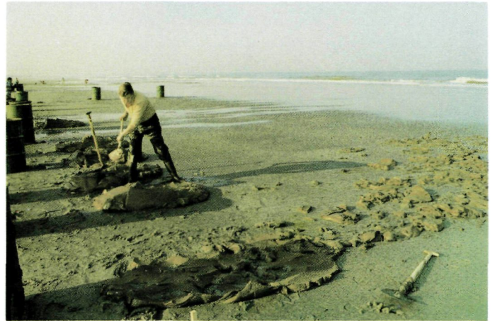
Twee uur voor laag water wordt begonnen met handkracht de mousse in een (ca) 1 cm dikke laag uit te spreiden.
