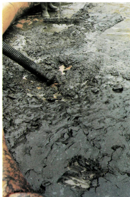
Ook nadat de mousse m.b.v. demulsifier is afgebroken zijn de restanten moeilijk uit de tussenopslag te verwijderen.
