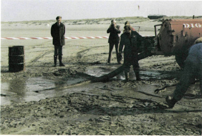
De gierwagen wordt getest om de verzamelde mousse af te voeren naar de tussenopslag.
