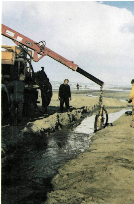
De hydraulische pomp (type TK5) wordt m.b.v. een kraantje door de sleuf gehaald.
