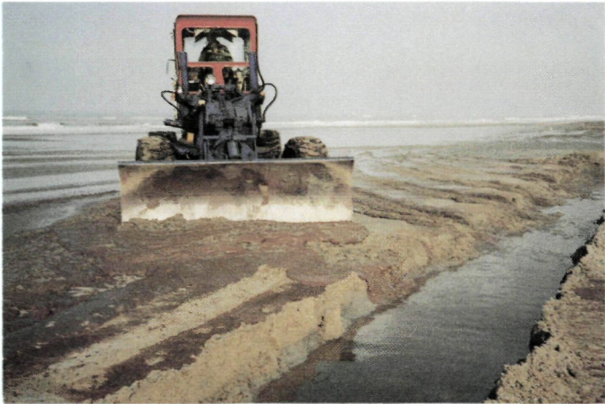
De mousse wordt door een grader in de sleuf geschoven.
