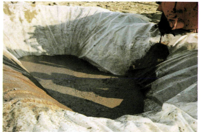
Ook de halfverzonken kuil met folie voldoet goed als tussenopslag.
