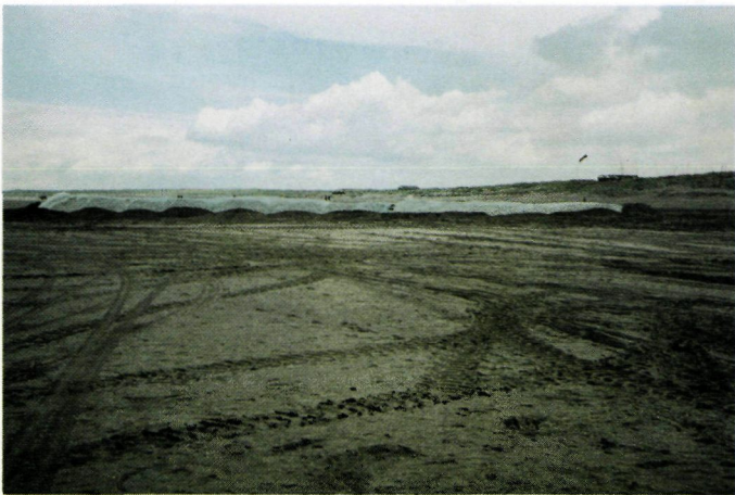
Alleen een aan zeezijde met folie beklede strandwal is in staat om kleine strandgedeelten gedurende enige dagen tegen een opkomende oelievloed te beschermen.
