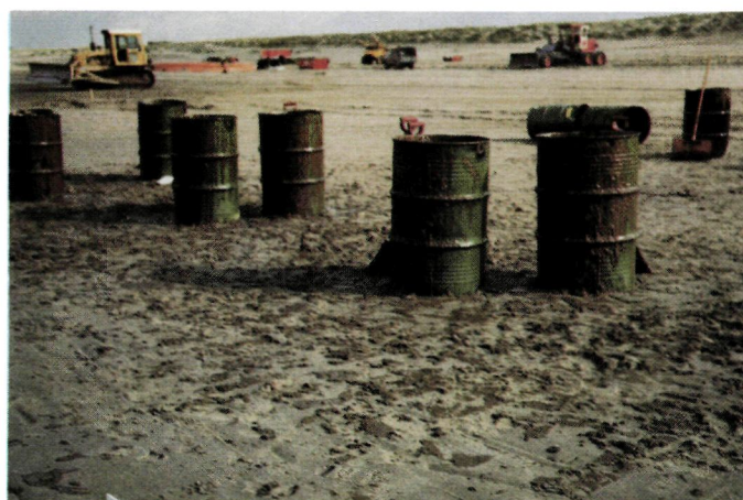
Met handkracht verzamelde mousse kan goed in vaten worden opgeslagen en afgevoerd.
