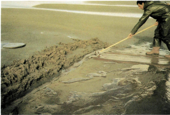
Diverse handschuifmiddelen zijn uitgetest. Wissers en bezems voldoen niet erg goed.
