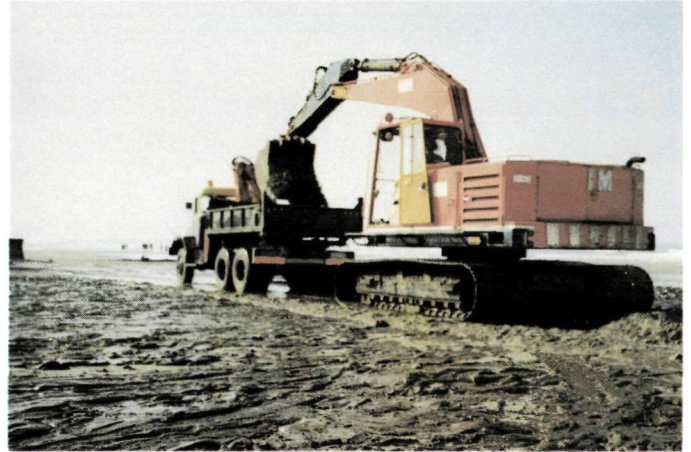
In het midden van proefvak C wordt een sleuf van 30 m lengte gegraven door een hydraulische graafmachine.
