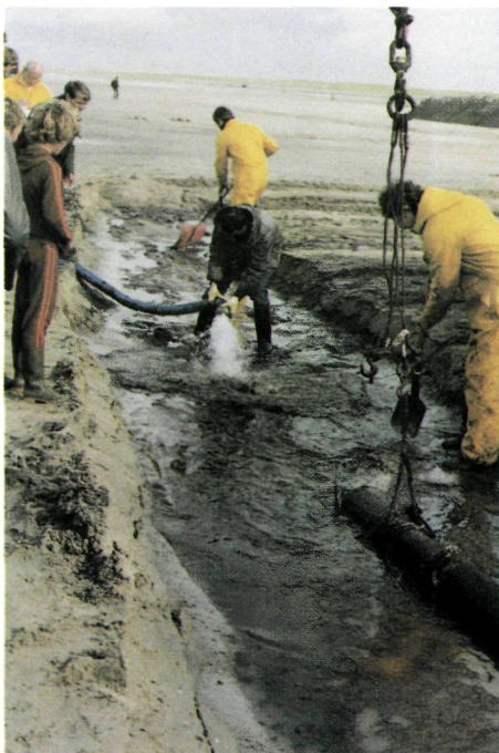
Met smalle schuiven (20-30 cm) en onder toevoeging van water wordt de mousse naar de pomp geleid.
