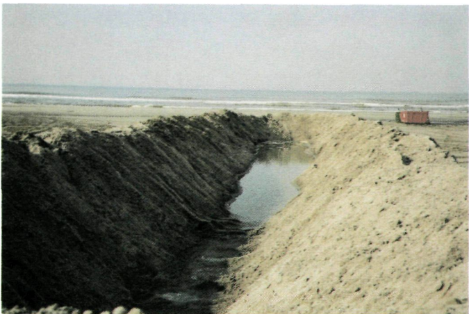
De bodem van de kuil dient bij voorkeur net onder water te staan.
