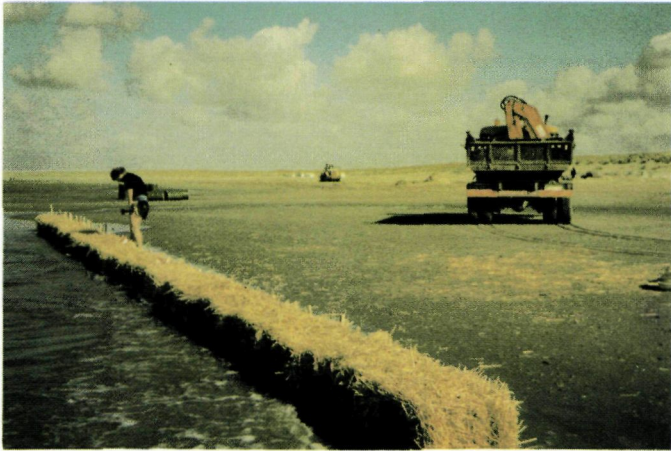
Het oliekerende en olieabsorberende strobaleenscherm slaat bij opkomend water kapot.
