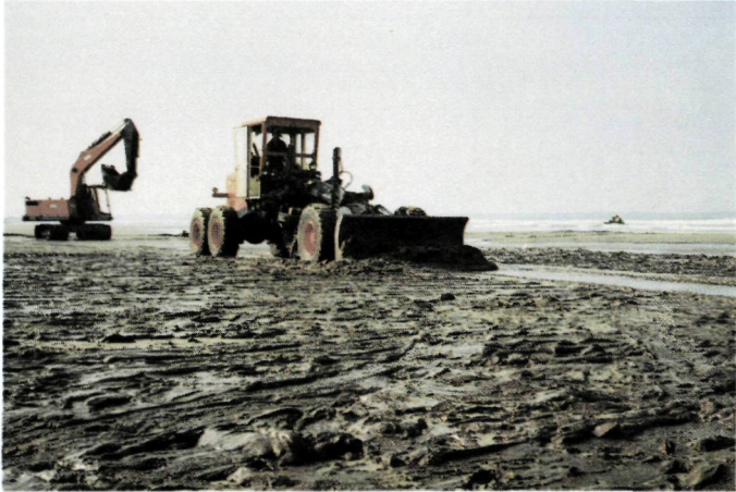
In het midden van het 500 m 2 grote proefvak wordt m.b.v. de grader een baan van 3,5 m moussevrij gemaakt.
