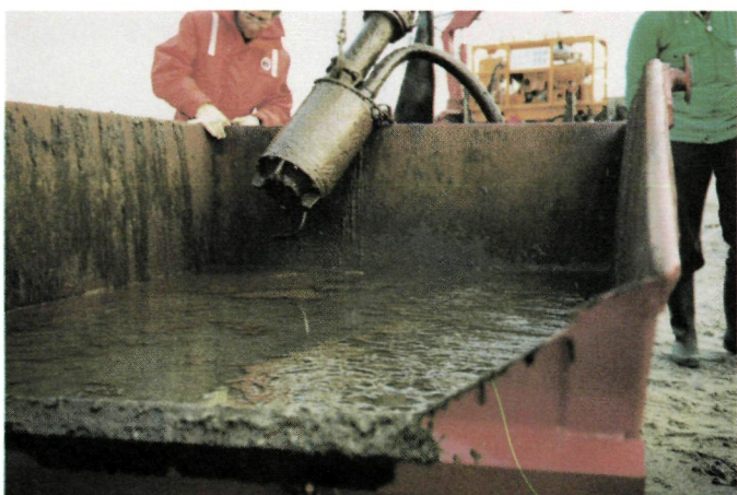
Containerbakken worden met ballast schoppen gevuld. Vanuit de container is een verpompproef uitgevoerd met demulsifier injectie.
