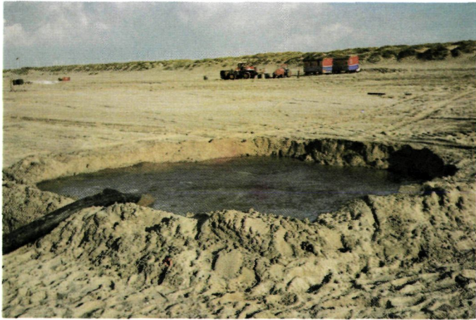
De halfverzonken kuil zonder folie voldoet als tussenopslag op het droge strandgedeelte uitstekend.
