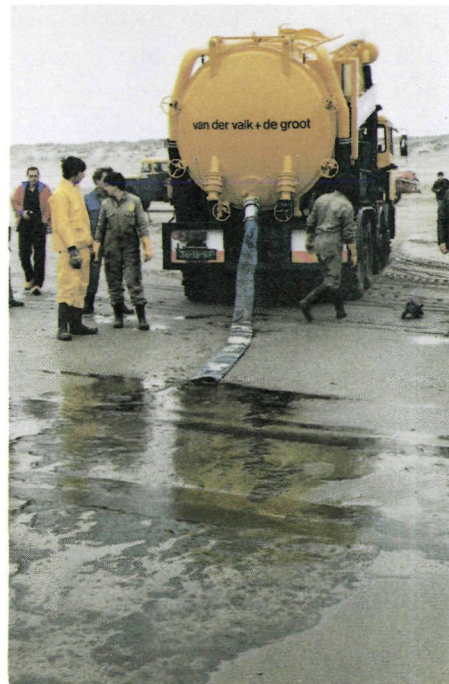
Het in de vacuümwagen afgescheiden water wordt afgetapt.
