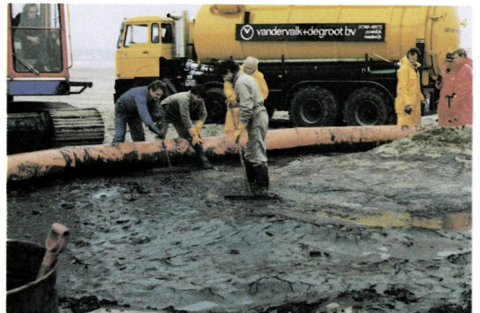
Het hoge zandgehalte van het in het drijfkraagbassin gedeponeerde mengsel gaf grote problemen bij het legen.
