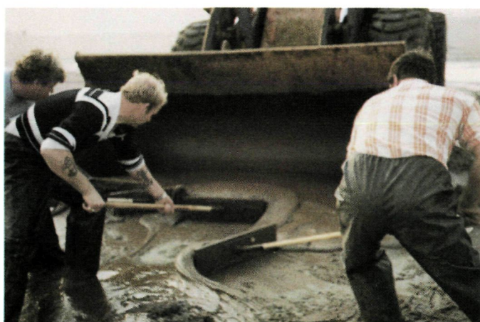
Met handkracht wordt de bak van de laadschop met mousse gevuld.
