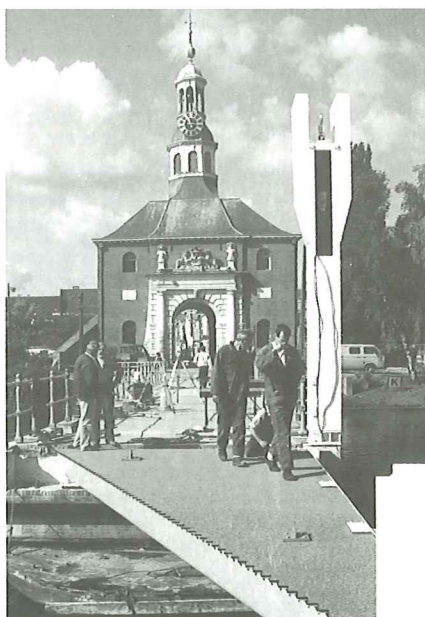
De Zijlpoortbrug, een driehoekig val in aanbouw. (foto H.J.J. Roelofs)
