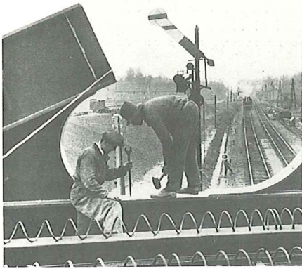
13. Brug bij Nuth; spiraalwapening op de langsliggers ten behoeve van de samenwerking met de daarop gestorte betonnen plaat. (Bron: Publieke Werken 1936, p. 182)
