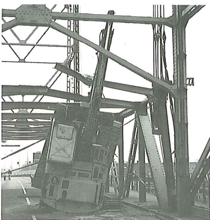
Aanrijding van de hefbrug over de Gouwe te Alphen aan den Rijn (Foto: Hollandia b.v.)
