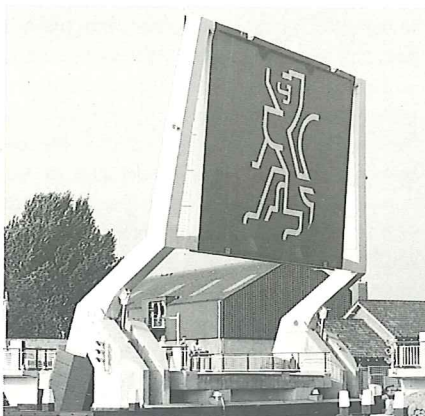
2. Vijfgatenbrug te Ter Aar (Foto: Land+Water/MT dec. 1995)
