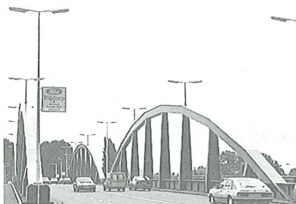
7. Het Stadionviaduct over het spoorwegemplacement te Rotterdam. (foto ir. K. Noorlander, Rotterdam)
