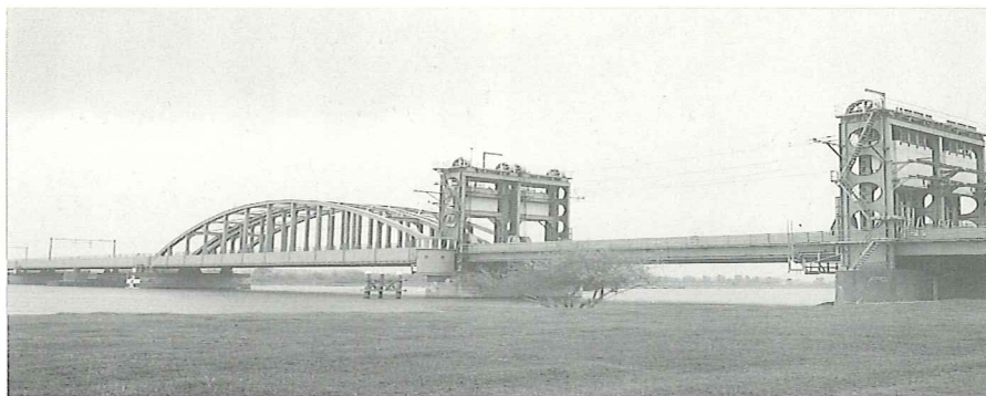
4. In 1935 gebouwde overbrugging van de IJssel te Hattemberbroek nabij Zwolle. (foto NS)
