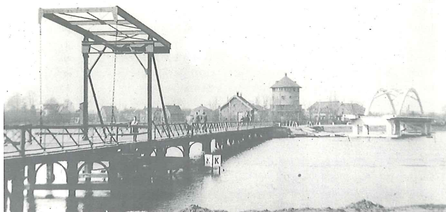
2. De oude Linge-brug en de toen pas voltooide betonboogbrug, gezien vanaf de Geldermalsense oever, tijdens hoogwater in januari 1940.
