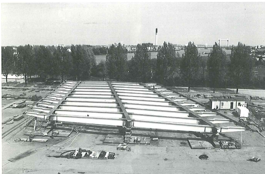
12. Composiet aanbrug van de Erasmusbrug in aanbouw
