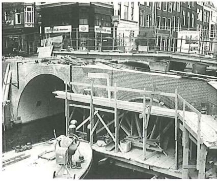
3. Het werk in uitvoering, mei 1995. (Foto NBS)
