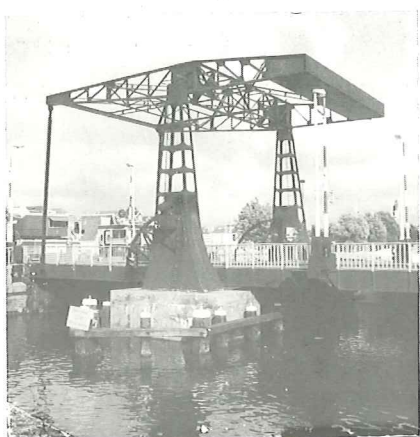
2. De Langebrug, ijzeren ophaalbrug uit 1933. (foto G.J. Arends)
