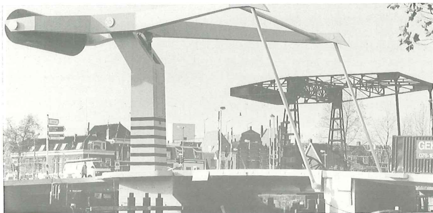
3. De nieuwe Langebrug met op de achtergrond de oude brug. (bron: Witteveen + Bos, foto United Photos de Boer bv)
