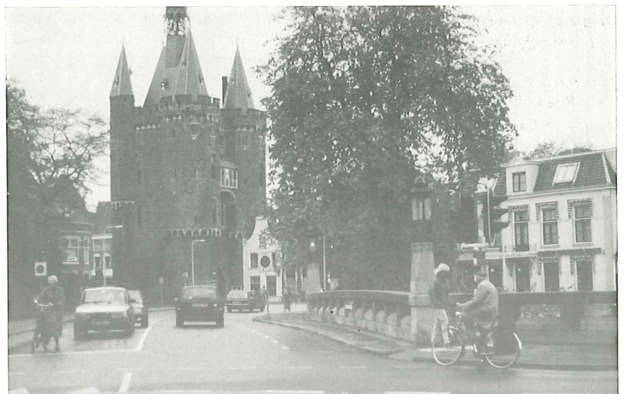
6. Een nieuwe straat op een oude brug
