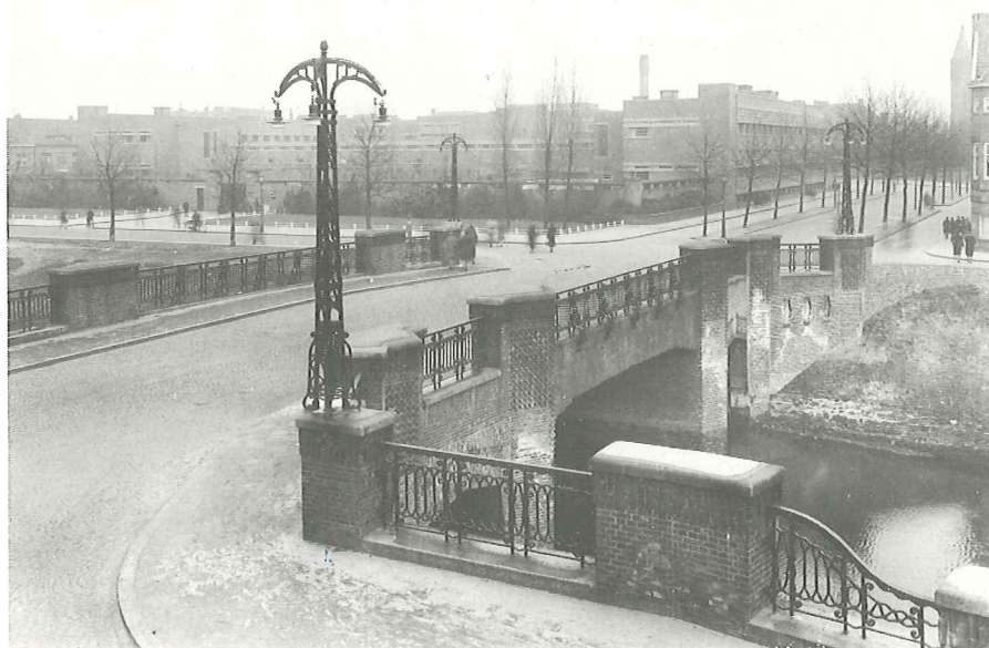
2. De Rückertbrug vanaf de Noordwal, op de achtergrond het 'HTS-gebouw' (foto dd. 4 februari 1939).
