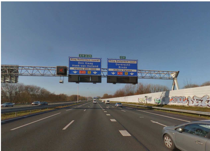
Bewegwijzering ter plaatse van het weefvak
