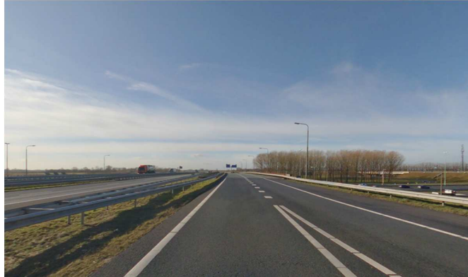
Parallelbaan langs de A15 Li (verbindingsweg y)
