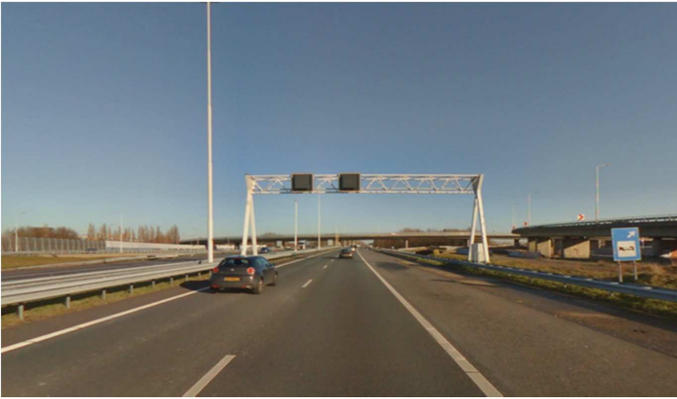
A20 ter hoogte van knooppunt Terbregseplein
