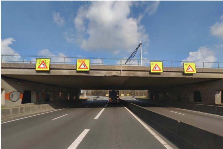
A16 ter hoogte van het spoorviaduct met waarschuwingsborden voor de krappe bogen
