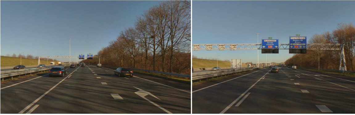
A20 ter hoogte van het begin van de uitvoegstroken naar de A16 (links) en vlak voor de splitsing van de rijbanen (rechts)
