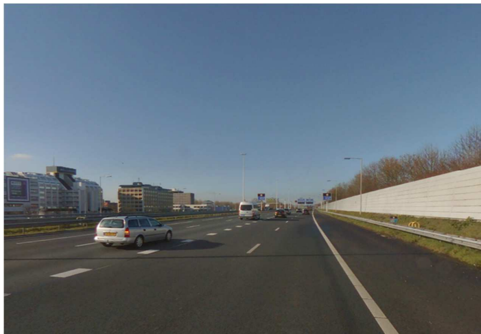
Weefvak gezien vanaf de toerit van de aansluiting Rotterdam Alexander
