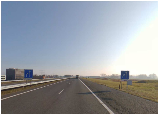
Bebording ter hoogte van de aansluiting Almelo-Zuid
