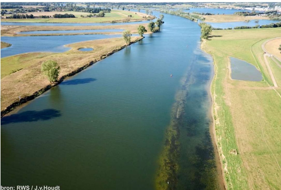
Figuur 1.4 Luchtfoto van de natuurvriendelijke oever Balgoij (rechts). De oever is enkele tientallen meters flauw aflopend afgegraven en de oever is met kleiig materiaal afgewerkt. Duidelijke zichtbaar is het smalle onder water gelegen dammetje van bestortingsmateriaal om de oever tegen golfslag te beschermen.
