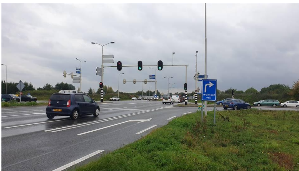
Figuur 22: Foto's schouw.
