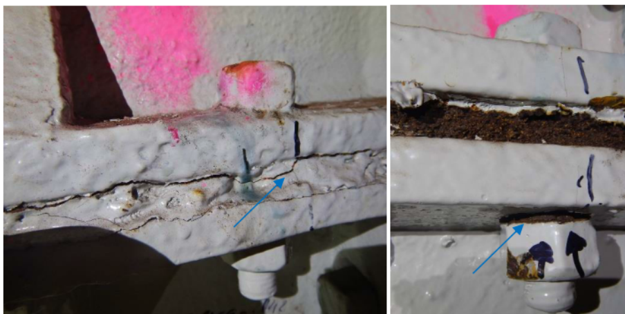
Figuur D 4 Twee oorzaken voor boutbreuk (foto's 4240 en 8465 uit [4]).
