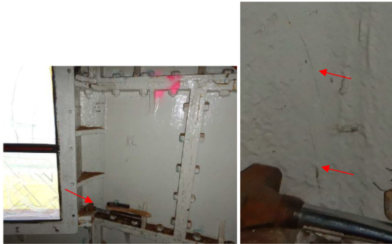
Figuur D 12 Foto's van scheuren met waarschijnlijk conservering over de scheur (foto's 8467 (2x) 7131 (2x) 4191, 4190, 8796 (2x), 7081 (2x) uit [4]).
