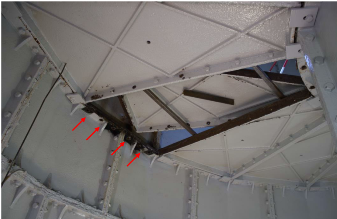
Foto 10 Vloer laag 15 - hier moeten bouten terug geplaatst worden
