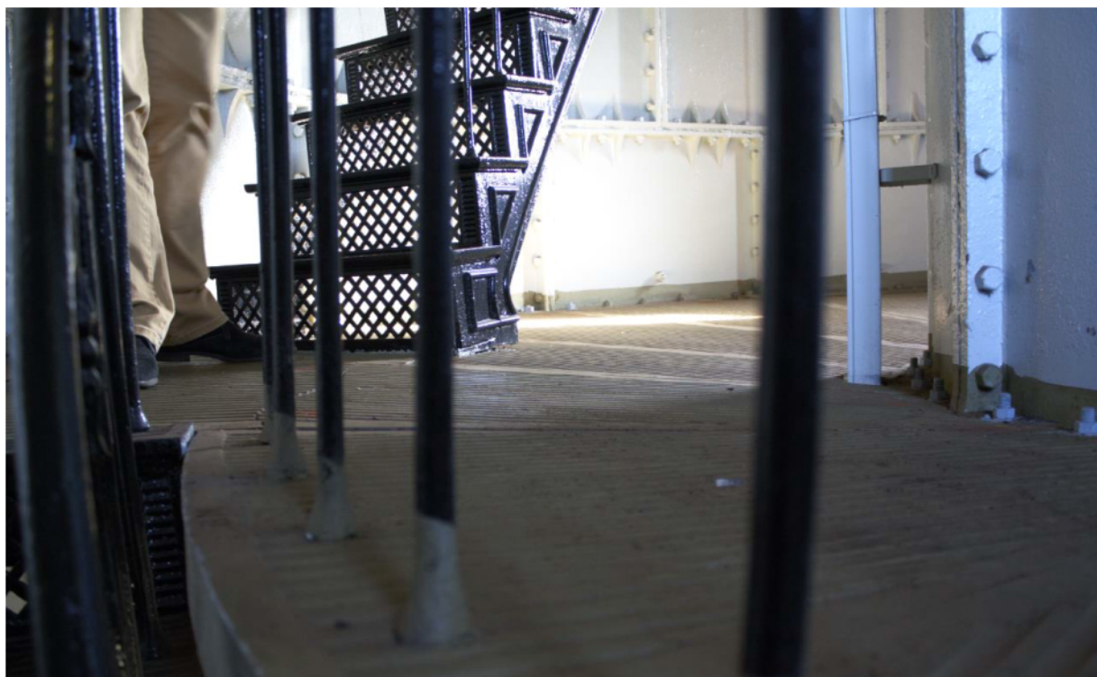
Foto 3 Bovenzijde vloer laag 13
