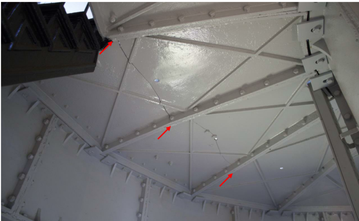
Foto 2 Vloer laag 13 vanaf andere zijde gezien
