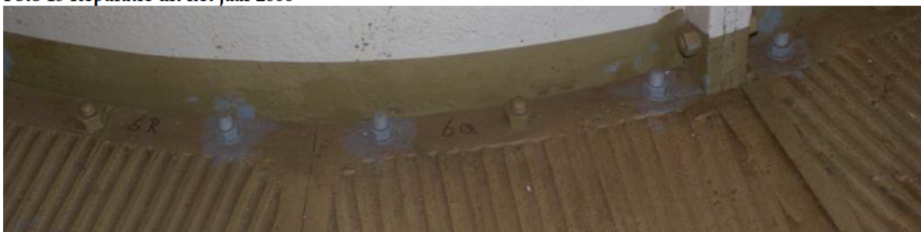
Foto 16 Bestaande bouten zijn vervangen
