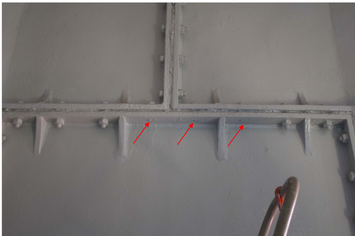
Foto 13 Laag 8 met afgebroken bouten
