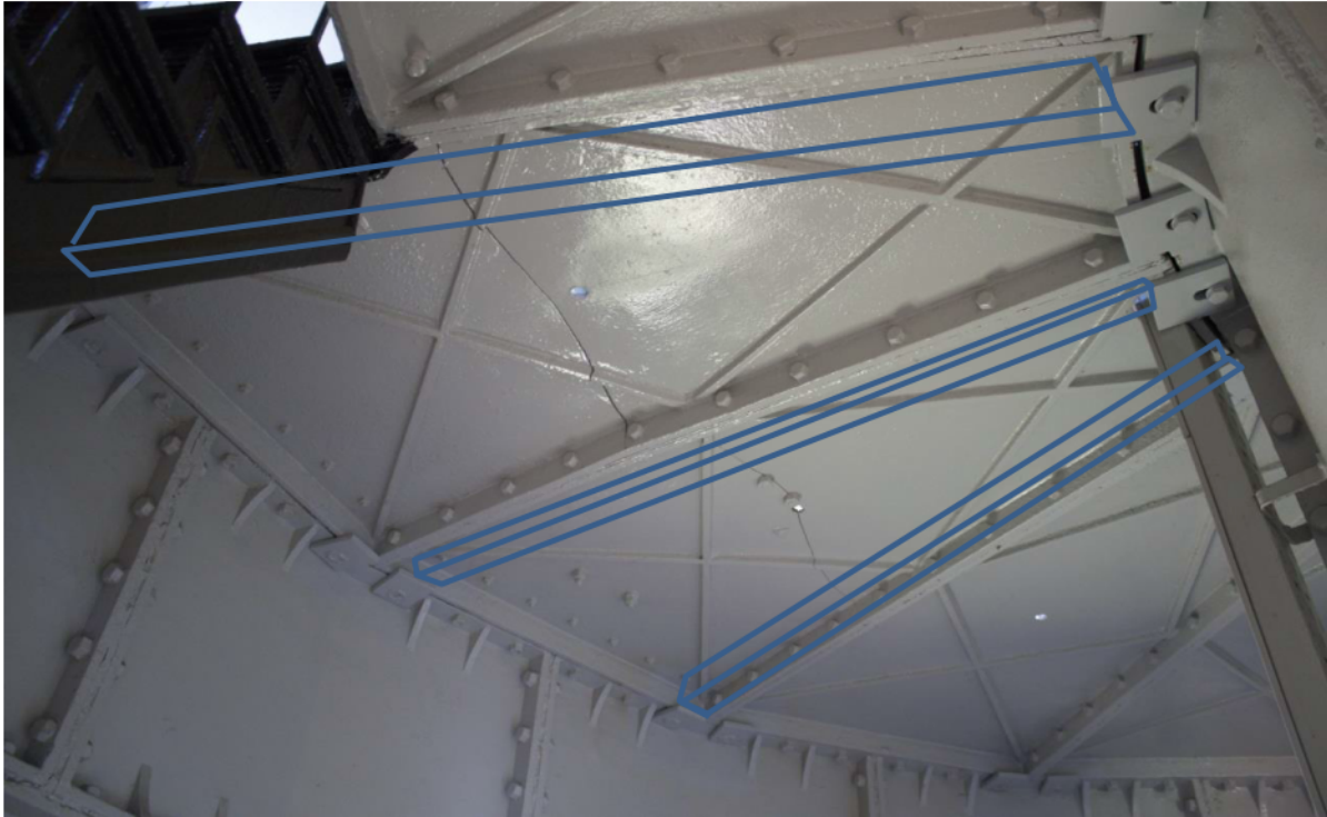
Foto 19 Laag 13 met daarin 3 houten balken geschetst t.b.v. opvang van de vloer (de stempels zijn hierin niet geschetst)
