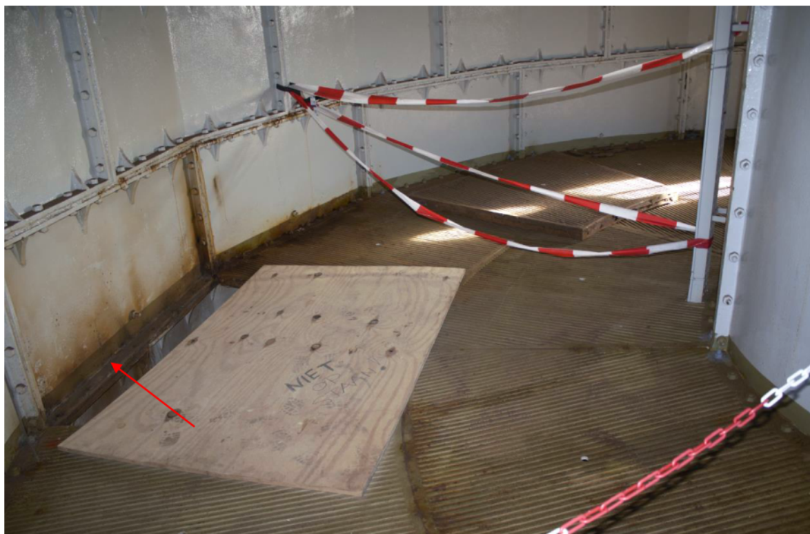
Foto 11 Vloer van laag 7 – de bouten moeten hier teruggebracht worden
