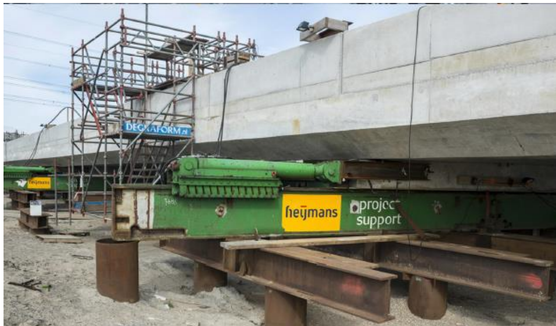
Figuur 6 - Vervangen viaduct
