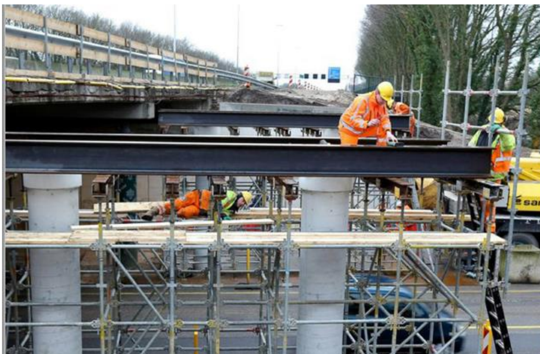
Figuur 7 - Vervangen viaduct
