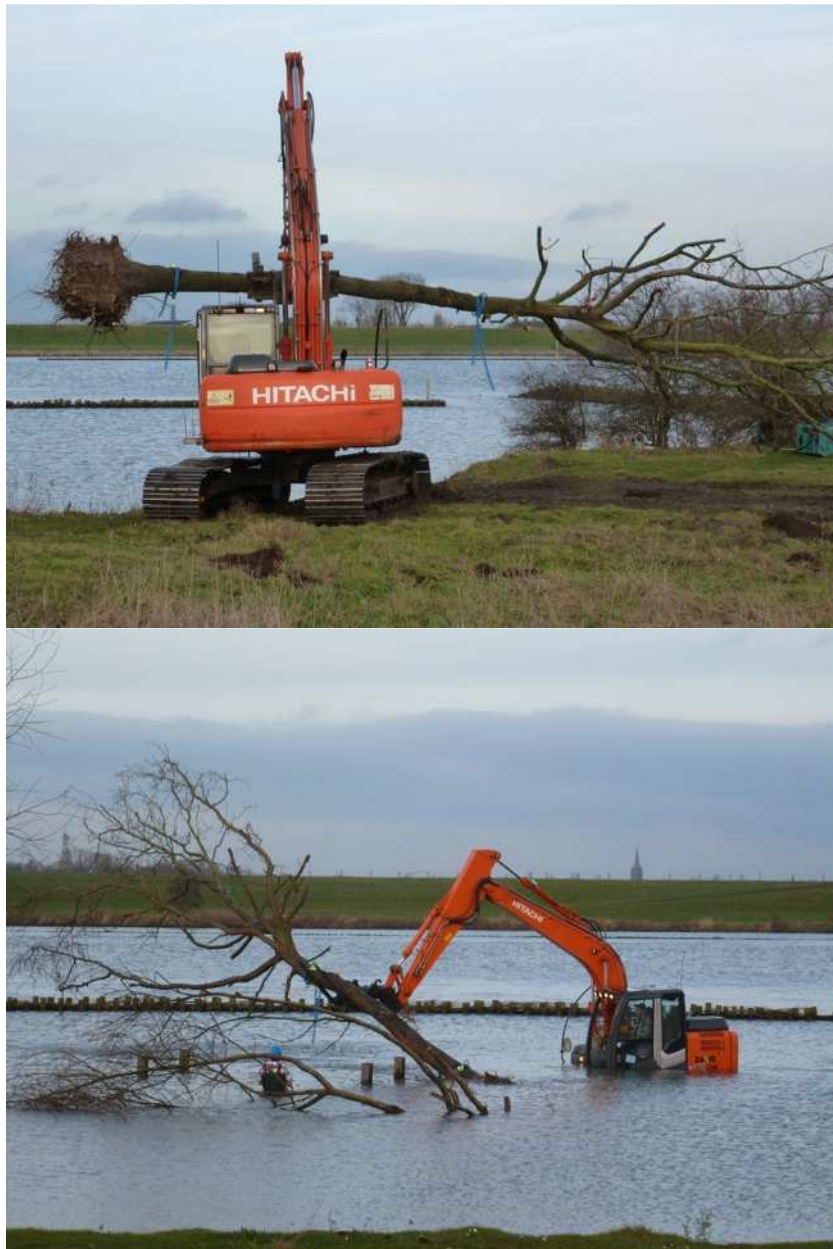
Foto 1 Het aanbrengen van bomen in een kribvak langs de Lek nabij Everdingen in januari 2014.
