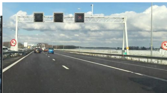
Afbeelding 42 en 43: IVV met onderbord spitsvensters (A9 hm 36.2 Li en hm 43.9 Re).
