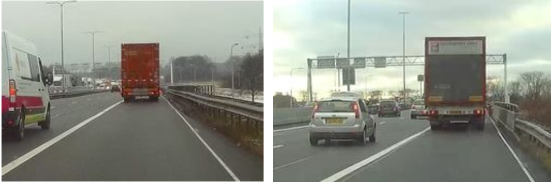
Afb. 23 en 24: Combinatie smal profiel en ontbreken redresseerruimte (viaduct Urmond en viaduct Echt)
