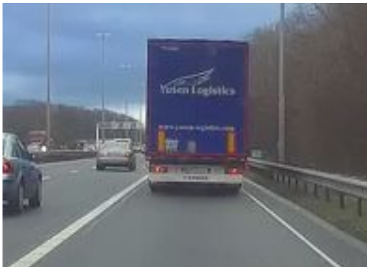
Afbeelding 22: A2 Vonderen –Urmond spitsstrook (3,28 meter) en beperkte redresseerruimte
