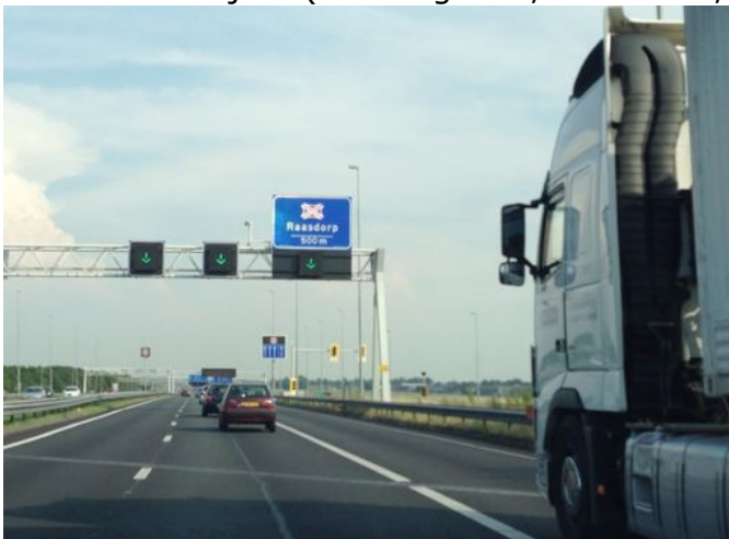
Afbeelding 15: De groene pijlen boven de weg en de doorgetrokken streep van een spitsstrook
