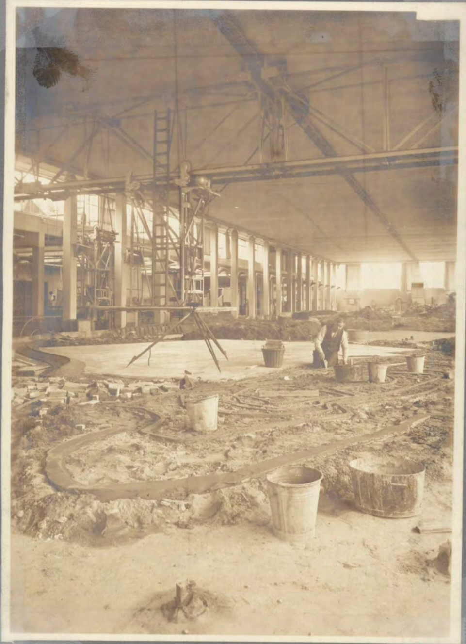
6. Het model in aanbouw.
