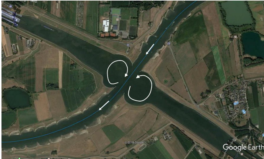
Figuur 7 Kruising van Amsterdam-Rijnkanaal en Nederrijn met behulp van de 'eieren', die zorgen voor ondersteuning van de stroming in het zomerbed van de Nederrijn en sedimentuitwisseling met de rivier beperken
