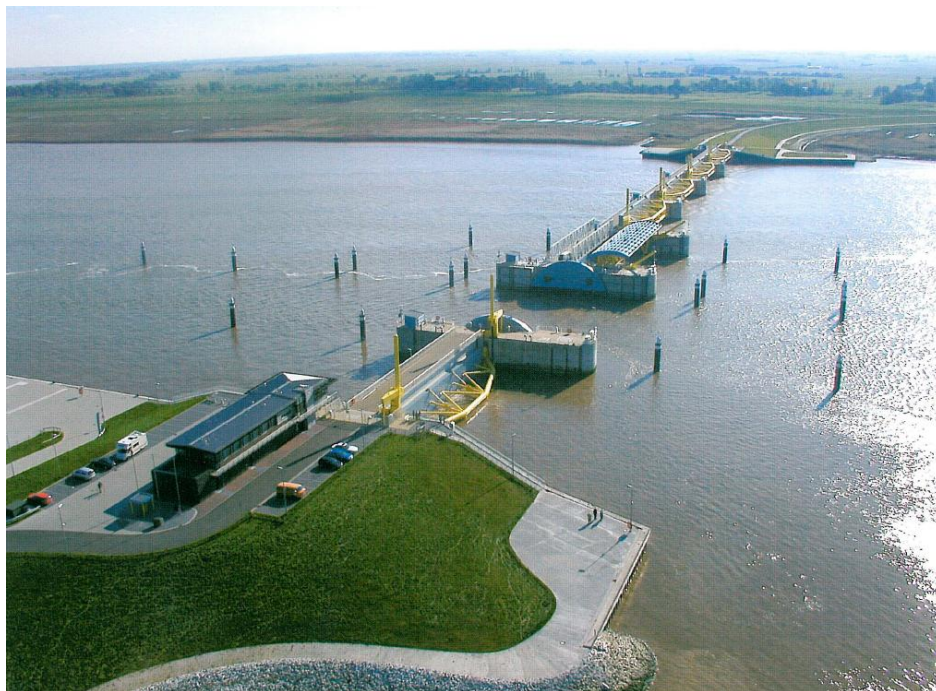
Figuur 5.2 Het Emssperwerk (uit: brochure Das Emssperwerk, NLWKN)
