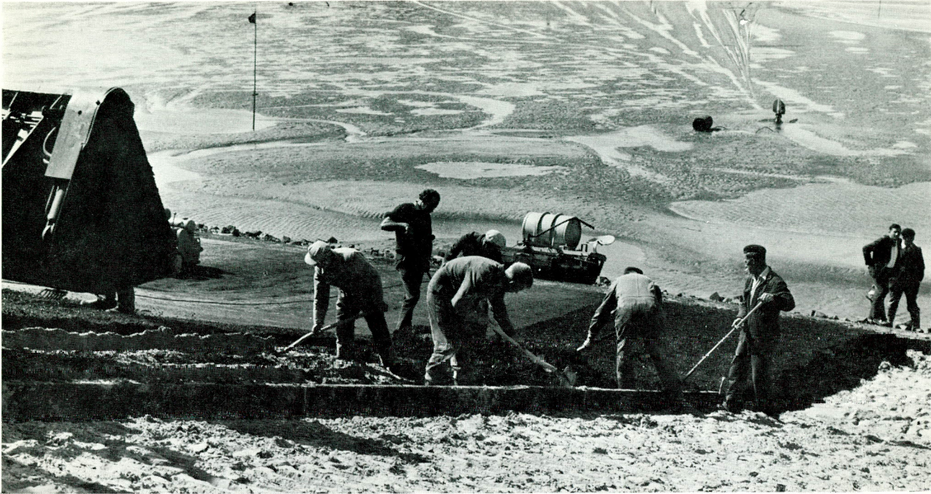
Fig. 31: Uitvlakken en harken van asfaltspecie
