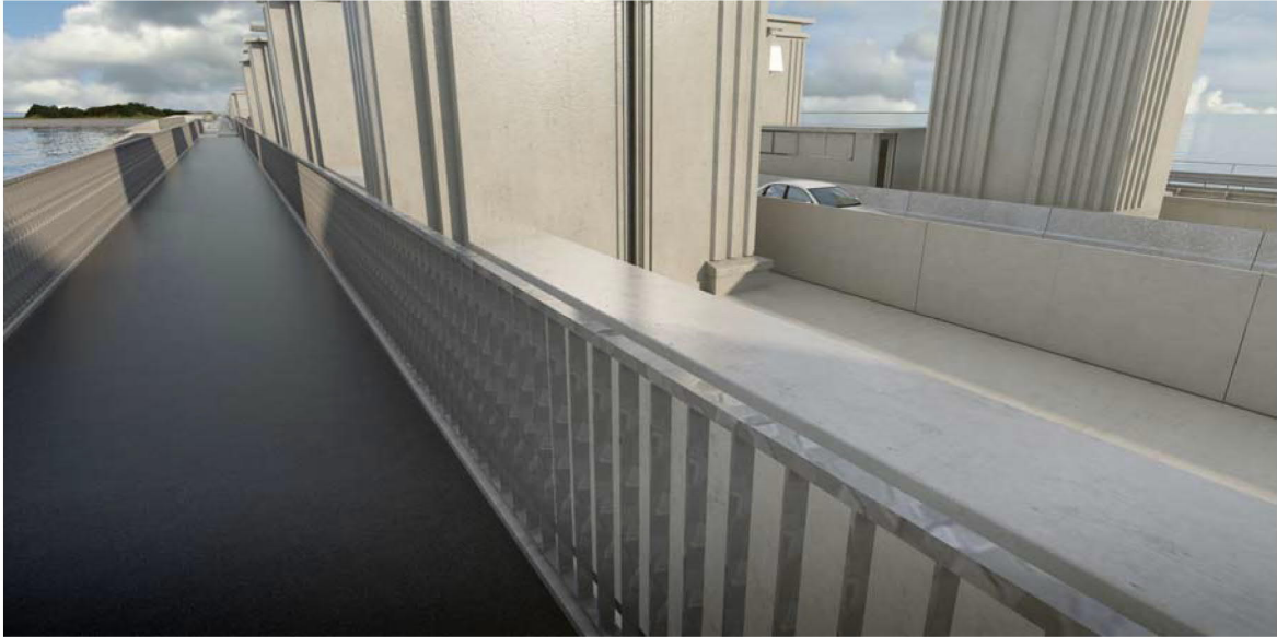
Figuur 9 BSM DOV met bovenbalken tot +7,0 m gezien vanaf fietsbrug
