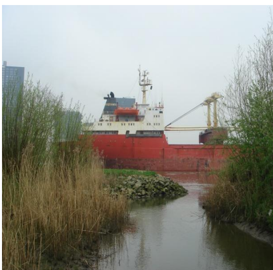
S-vormige opening dempt scheepvaartgolven.
