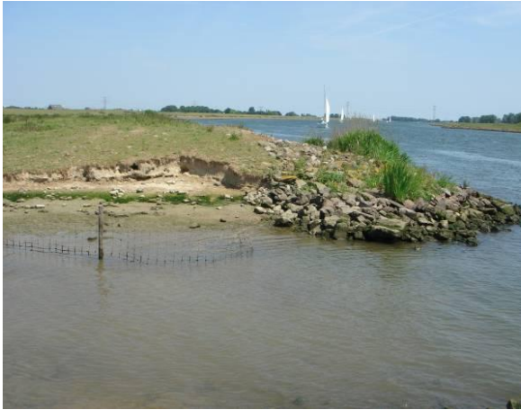
Erosie en steilrand aan instroom aan zuidzijde (aan eiland).
