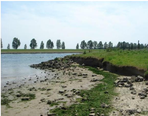
Erosie en steilrand aan instroom aan zuidzijde aan de landzijde.
