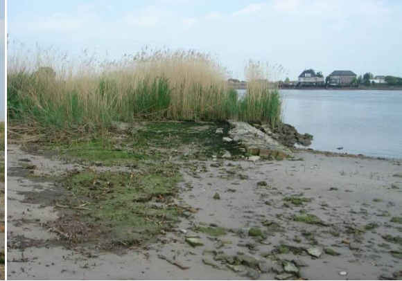
Voormalige krib, bovenstrooms, erosie stenen weggeslagen.
