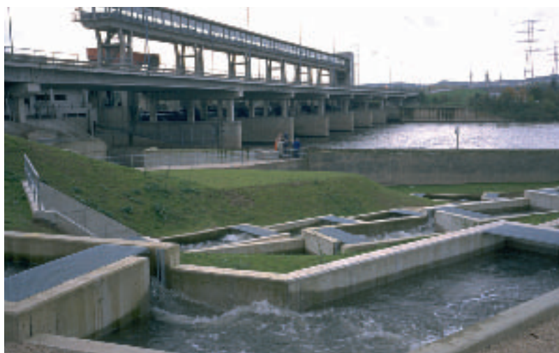
Foto 1: De oude 'Denil'-vispassage in de stuw bij Lixhe in de Maas (rechts). Deze vispassage bleekt slechts geschikt voor een beperkt aantal soorten. Daarnaast was het aanlokkende werking gering omdat door deze vistrap weinig water stroomt. Inmiddels is een nieuwe vispassage volgens het model 'vertical slot' aangelegd (boven). (foto's Tom Buijse).
