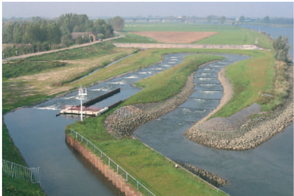
De in 2004 gereed gekomen vispassage bij Hagestein in de Lek. De drie stuwen in de Neder-Rijn en de Lek zijn nu allen voorzien van vispassages. De vispassages zijn een combinatie van V-vormige drempels met in het midden een verticale spleet ('vertical slot'). Nagenoeg alle soorten en groottes kunnen door deze passages stroomopwaarts trekken (foto Tom Buijse).
