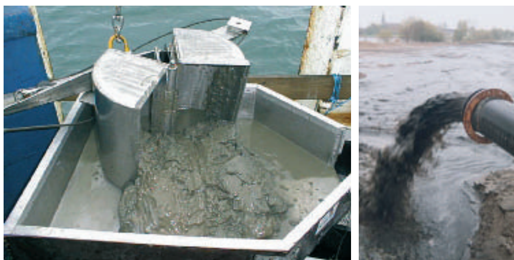
Verontreinigde waterbodems en baggerspecie leiden tot knelpunten bij de uitvoering van projecten met grootschalig grondverzet (foto Marcel Tonkes)
