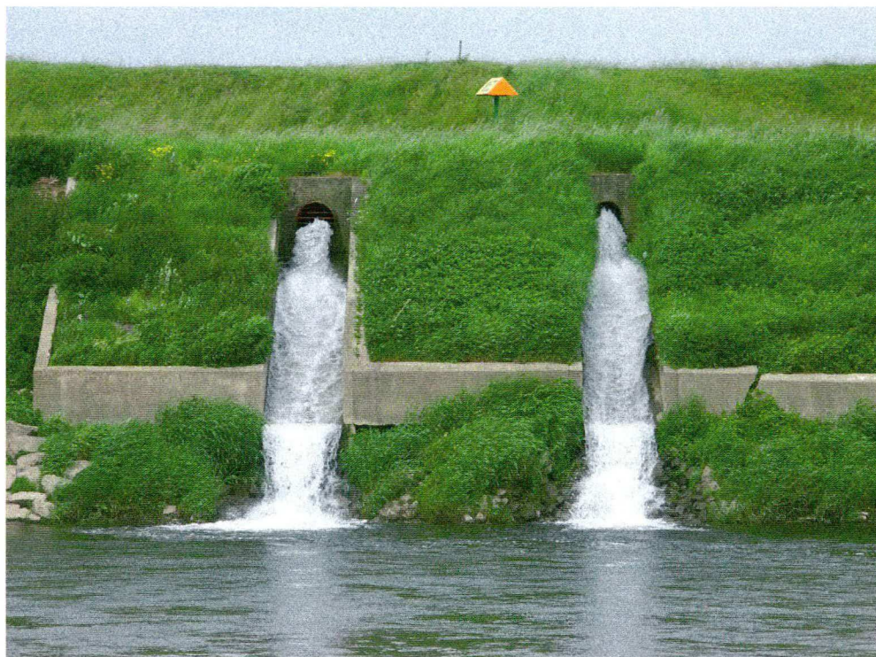
Lozing van opgepompt grondwater op de Maas
