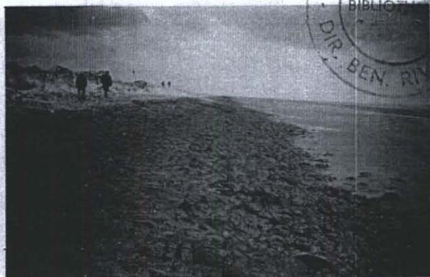
Weggeslagen bekrammante zoden en vernielde top.
