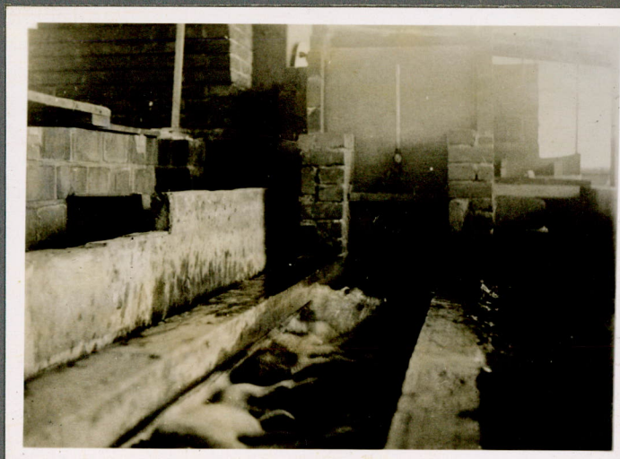
f. uitstrooming in het riool (stroomtype b)
