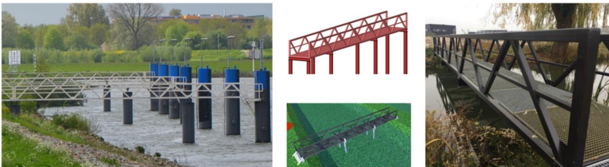
Figuur 5.1 Bij de verbreding van het Lekkanaal hebben enkele van de vrijgekomen loopbruggen een nieuwe functie gekregen als parkbrug binnen hetzelfde areaal. Het betreft hergebruik op element niveau.
