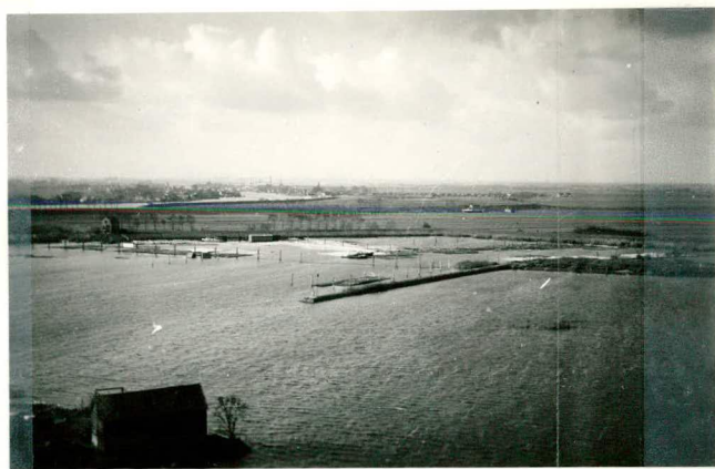
Overzicht terplaatse van krib 12 op den achtergrond loswal III;
