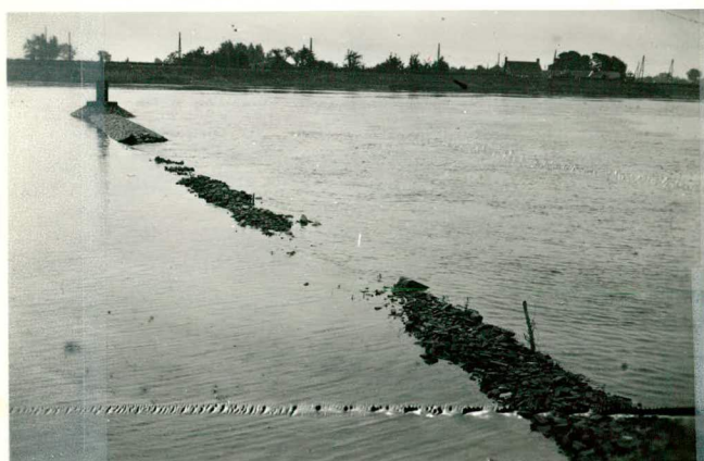
Aanzicht der kribben voor de be- kleeding; tekst pag. 165.
