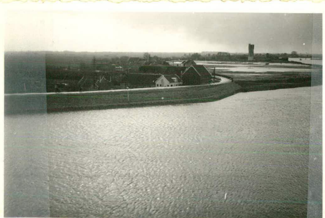
Aansluiting loswal III van Haaften aan dijk der Krimpenerwaard.
