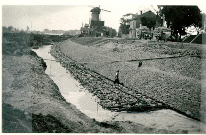
Afgraving "Molenplaats"; aanleg steenglooiing en kraagstukken in den droge; tekst pag. 154.
