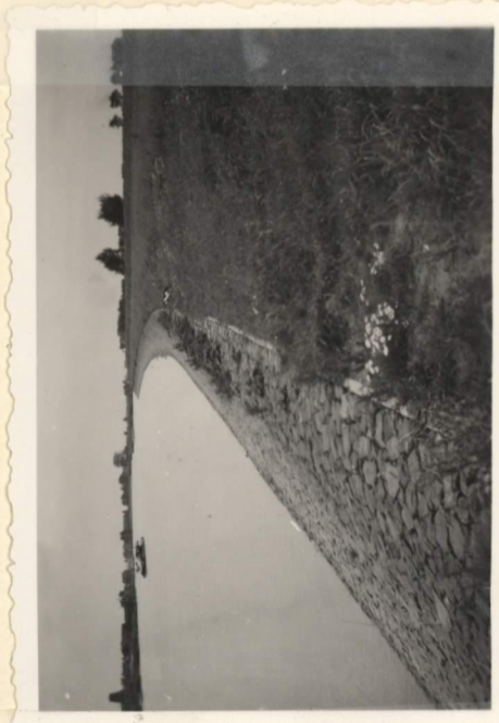
Overzicht van de ophooging langs Schielands dijk tus s s c h e n k . m . r . 14.000 en 14.300;
