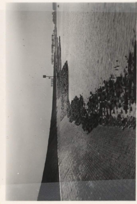
Glooiing van klinkerkeien tegen het beeloop van loswal III.; tekst pag. 69.
