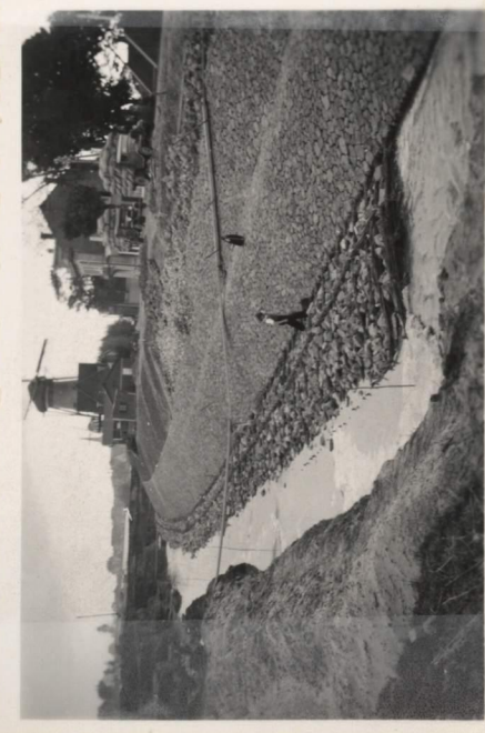
Afgraving "Molenplaats"; aanleg steenglooiing en kraagstukken in den droge; tekst pag. 154.
