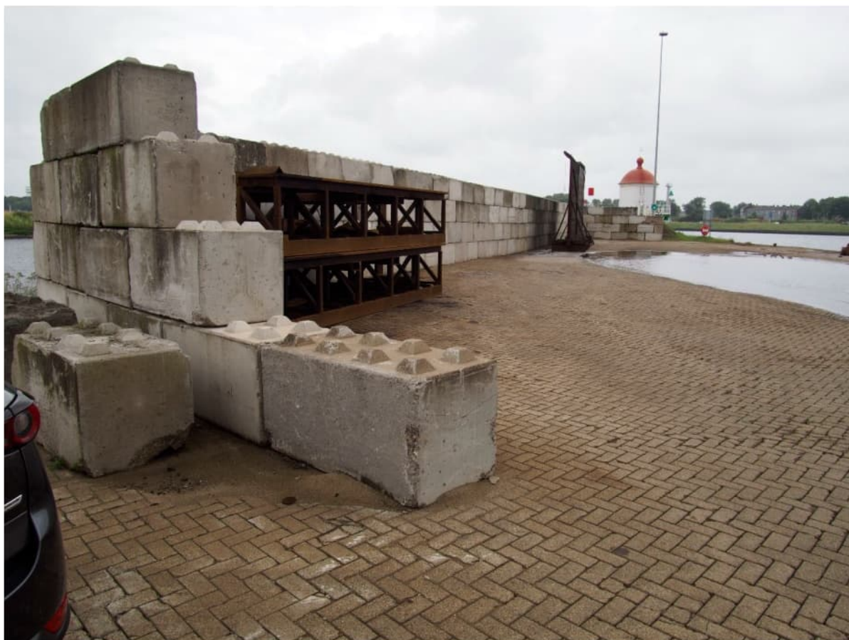
Figuur 5: Keerwand van 'mega-blocks'
