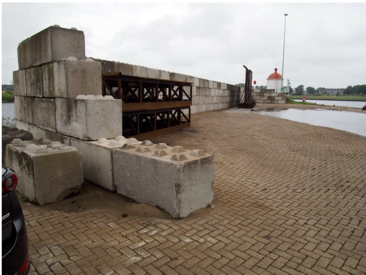
Figuur 5: Keerwand van 'mega-blocks'
