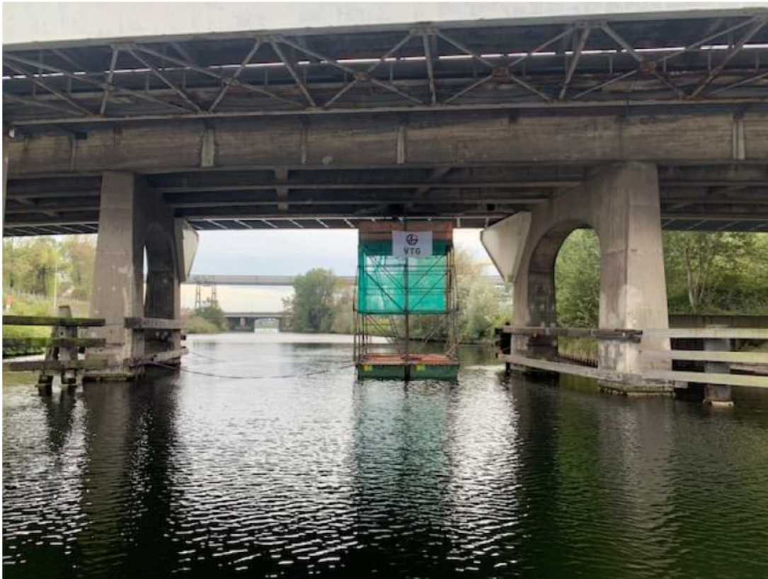
Voorbeeld: opstelling steigervoorziening (2020)
