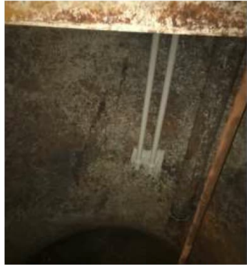
Afbeelding 3: verlengde instroomleidingen
