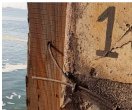
Figuur 3: Aanwezige gaten in wrijfstijl
