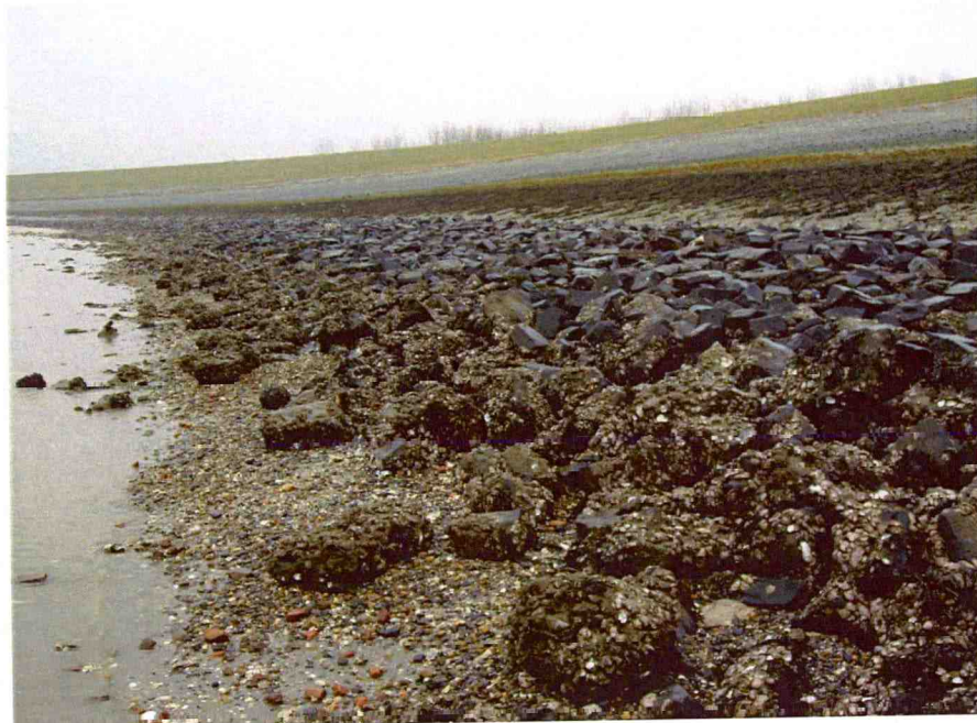
Foto 3.6 Een kreukelberm als teenconstructie
