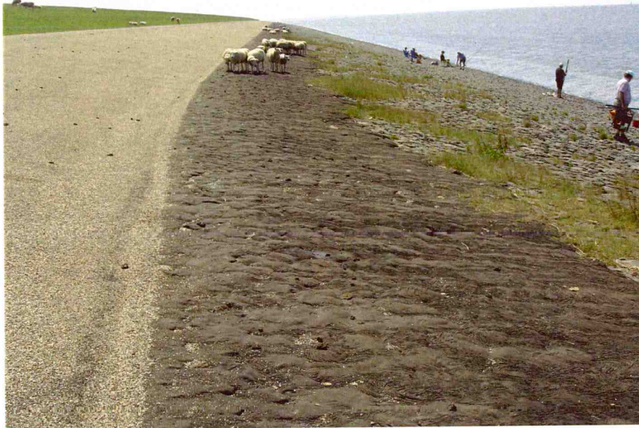
Foto 3.4 Bovenlud (gras), berm (asfalt) en benedentalud (eerst gepenetreerde basalt en daarna basalt).
