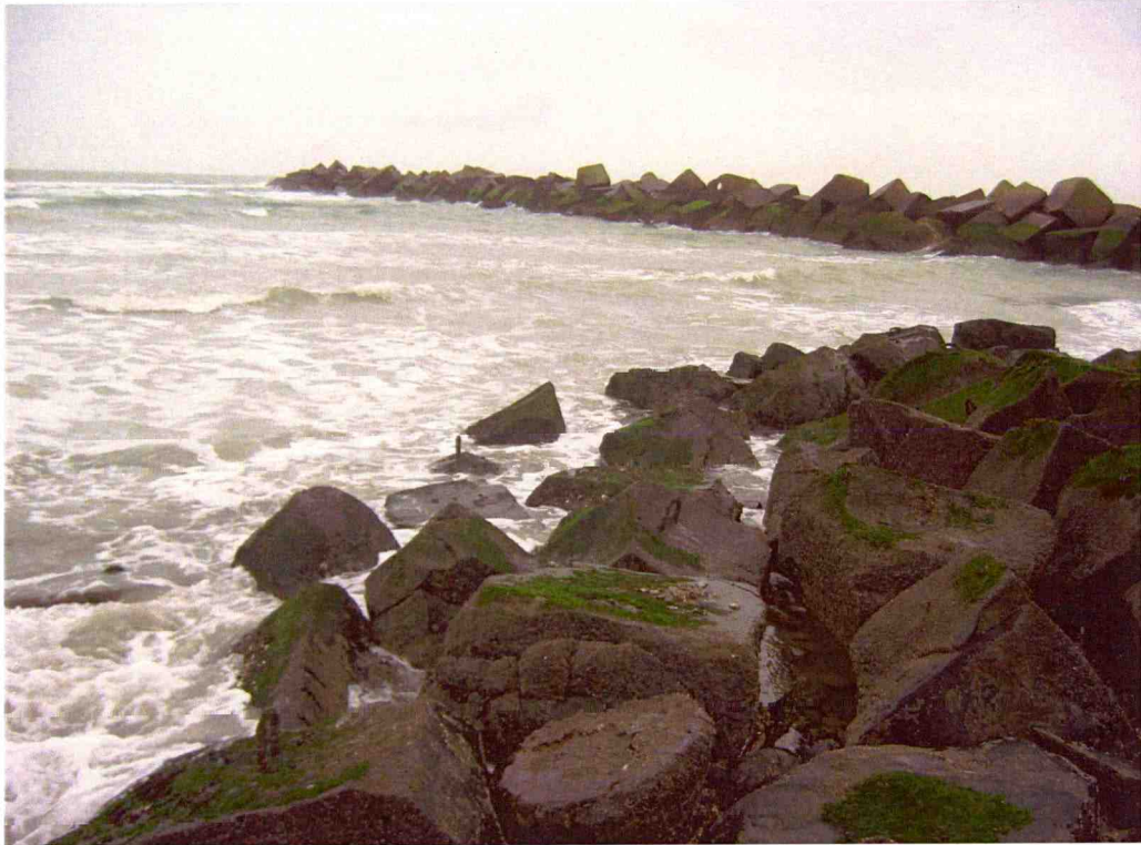
Foto 2.1. Geëxposeerd hard substraat (breuksteen - onderste deel foto) nabij Blokkendam (bovenste deel foto) op de Maasvlakte. Op iets luwe locaties treffen we al groenwieren ( Enteromorpha sp.) aan. Substraat is Doornikse kalksteen van 1-3 ton.
