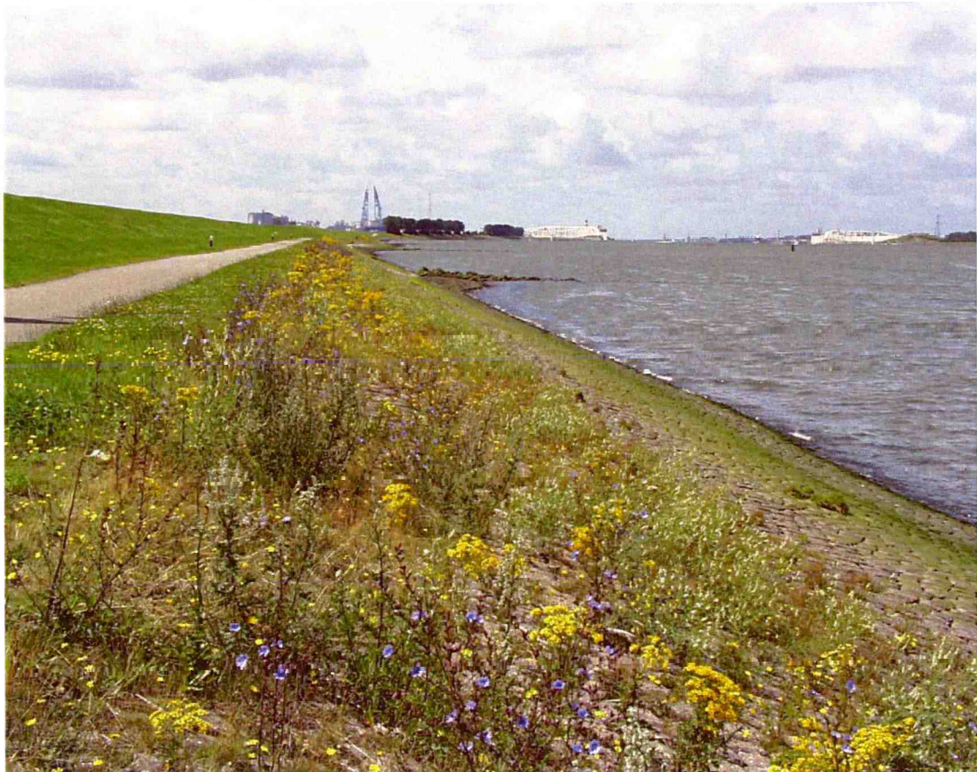
Figuur 6.5a-c Locatie langs de Nieuwe Waterweg, kribvak stroomopwaarts van Maesland kering. Ondiep beschut 3.4, Palenbos.
