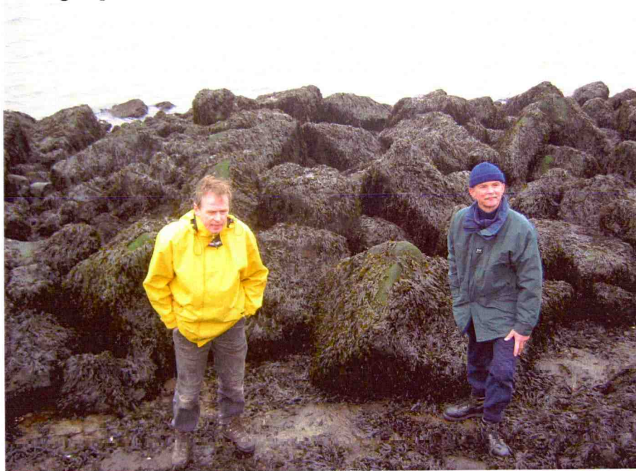
Foto 2.5. Uitbundig met bruinwier (met name Fucus vesiculosus ) begroeide berm van stortsteen (Doornikse kalksteen, gewicht 2-3 ton) in meer beschutte zone nabij Maasvlakte (ingang Hartelkanaal, tegenover Papegaaiebek).
