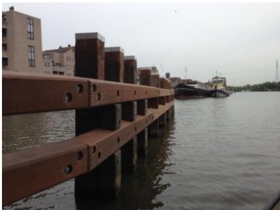
Figuur 4.4 Remmingwerk op de Donge (bron: Wijma Kampen)
