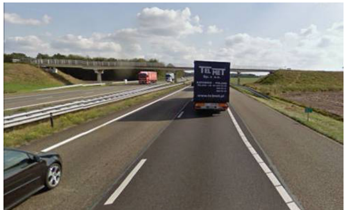
slanke brug over A67
