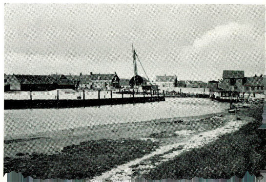
fig. 164. Overzicht van de oude haven te Kamperland.
