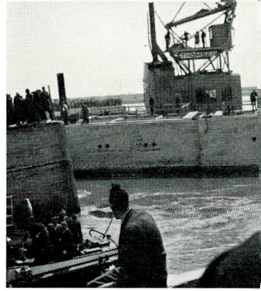
fig. 211. De „deur” van de Zandkreekdam draait dicht, 4 mei 1960.
