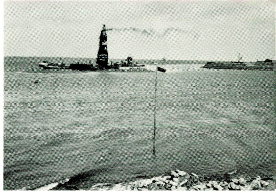
fig. 161. Begin van aanleg van de Vissers- haven te Colijnsplaat.
