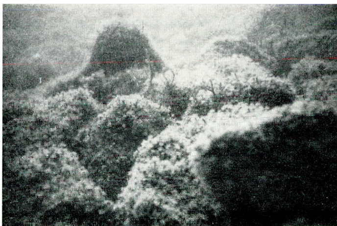
fig. 145. Begroeide stortsteen in de Oosterschelde, diep ca 6,50 m—L.W.
