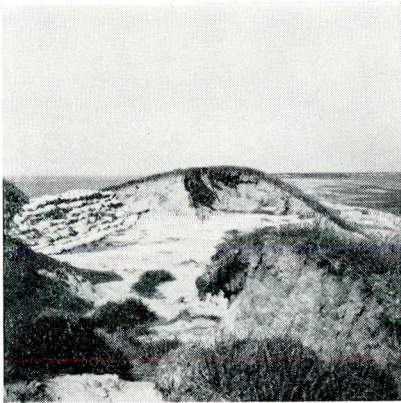
← fig. 86. Oud Noord-Bevelandpolder. Dijkbeschadiging bij dijkpaal 26.
