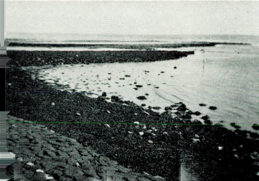
fig. 101. Verbindingsdammen van het noordelijk oeverwerk aan de cal. Leendert Abraham-polder bij L.W. (1951).
