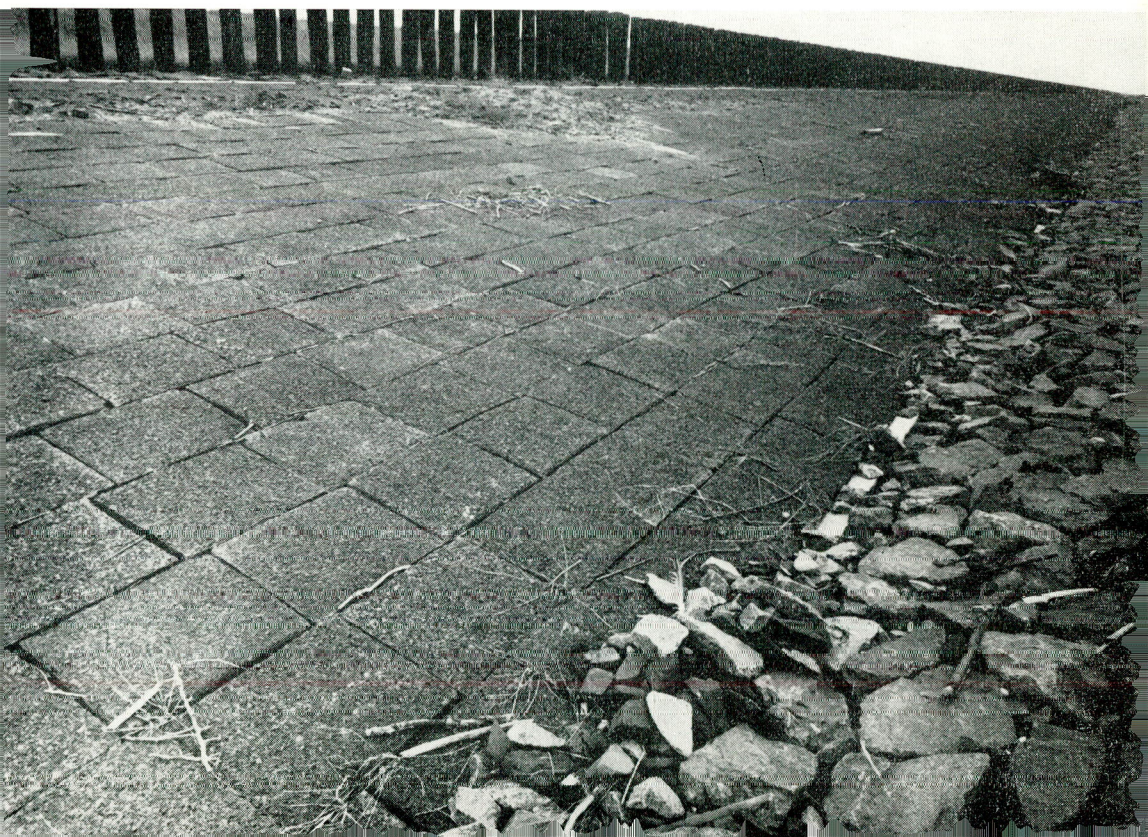
fig. 136. Glooiing van koperslabblokken aan de Torenpolder. (Eerste toepassing op Noord-Beveland, aangebracht in 1956.)
