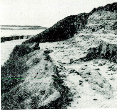
← fig. 83. Nieuw Noord-Bevelandpolder. Binnentalud-afschuiving nabij de kop van de Oostnol. Kop wordt verdedigd door betonplaat.
