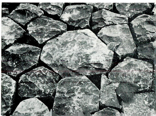
fig. 126. Basaltglooïing (nieuw), nog „ongestopt”.
