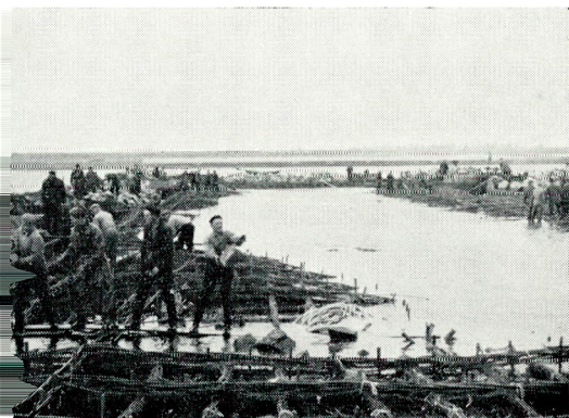
fig. 103. Zinkwerk aan de cal. Leendert Abraham-polder in 1958. Het stuk wordt geballast.
