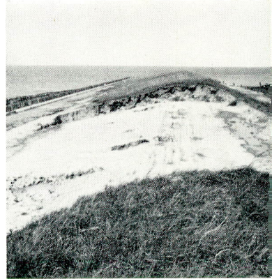
fig. 87. Oud Noord-Bevelandpolder (Glasjesnol). Dijkverhoging is weggespoeld.
