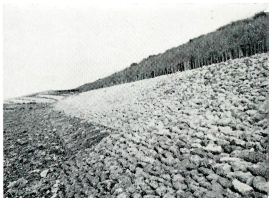
fig. 123. Vilvoordse steenglooïing aan de cal. Vlietepolder (nieuwe Westnl).
