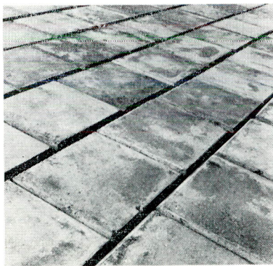
fig. 132. Trapjesbetonglooïing (systeem Leendertse) aan de cal. Onrustpolder.
