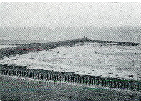
fig. 111. In 1859 aangelegde „afsluitdam” ten oosten van Colijnsplaat, opname 1960.
