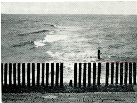
fig. 107. Situatie bij H.W. ter plaatse van de dam in fig. 106 (1960).
