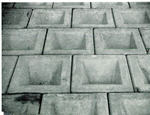
fig. 133. Betonblokkenglooïing (systeem Haringman) aan de Zandkreekd.
