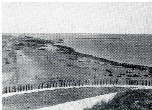
fig. 61. Oeverval van 10 januari 1939 aan de Al te Kleinpolder. Een oppervlakte van ca 4,5 ha verdween onder L.W., opname 1951.
