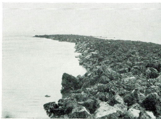
fig. 63. Beschadigde dam bij de oeverval van 28 maart 1951 aan de cal. Leendert Abrahampolder.
