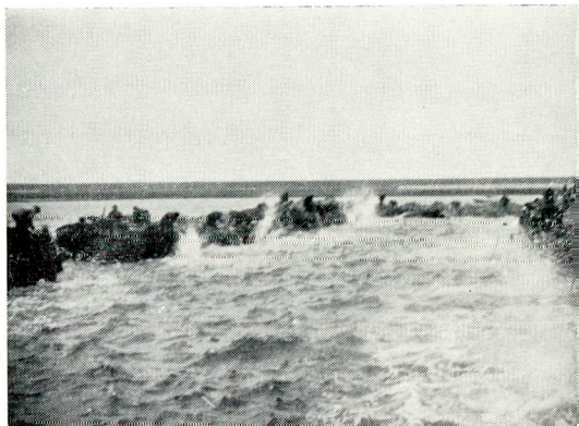
fig. 104. Zinkwerk aan de cal. Leendert Abraham-polder (1958). Het stuk is zo juist gezonken.
